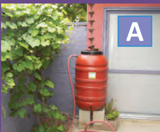
Barril de lluvia con desbordamiento en maceta
