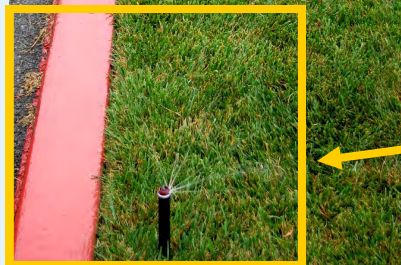
Rociadores nuevos con Boquillas Giratorias y vástagos de Compensación de Presión que elimina el exceso de rociado en la calle.
